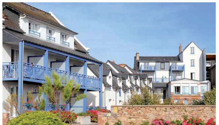
RÉSIDENCE LES BAINS - Trégastel
