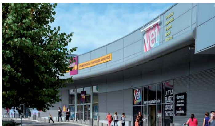
LES PORTES DE L'OISE - Chambly
