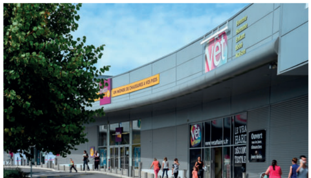
LES PORTES DE L'OISE - Chambly
