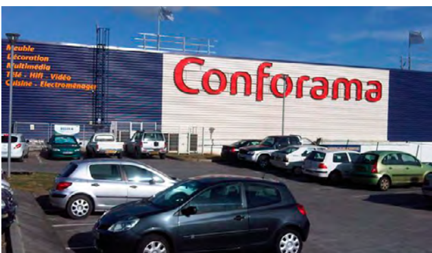
LE LAMENTIN - Fort-de-France
