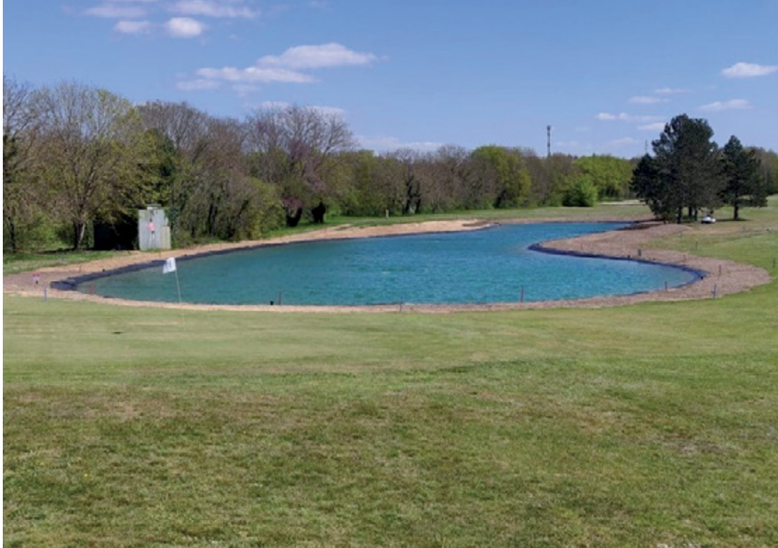
Rénovation du bassin de stockage : 2 650 m 3 > 4 000 m 3 Golf de Bourges (18)
